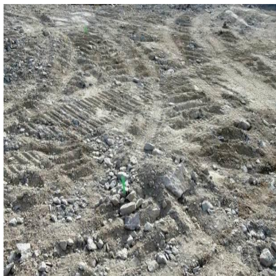
17 Сурет – Маркшейдерлердің ұңғыма орындарына белгі қоюы
